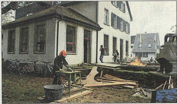
Beim Ausräumen des Jugendhauses wurde auch schweres Gerät (Kreissäge) eingesetzt.
